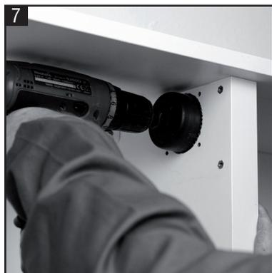
**Riprendere la foratura con la punta a tazza (C) Ø 64 mm nel lato sinistro del fianco centrale per forarlo completamente** / Riprendere la foratura con la punta a tazza (C) Ø 64 mm nel lato sinistro del fianco centrale per forarlo completamente / Riprendere la foratura con la punta a tazza (C) Ø 64 mm nel lato sinistro del fianco centrale per forarlo completamente / Riprendere la foratura con la punta a tazza (C) Ø 64 mm nel lato sinistro del fianco centrale per forarlo completamente.
