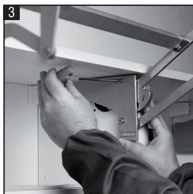
**Rimuovere le tre brugole di fissaggi dai carter laterali e centrali del vecchio meccanismo** / Rimuovere le tre brugole di fissaggi dai carter laterali e centrali del vecchio meccanismo / Rimuovere le tre brugole di fissaggi dai carter laterali e centrali del vecchio meccanismo / Rimuovere le tre brugole di fissaggi dai carter laterali e centrali del vecchio meccanismo / Rimuovere le tre brugole di fissaggi dai carter laterali e centrali del vecchio meccanismo.
