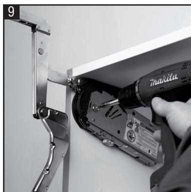
**Avvitare i meccanismi Blum Aventos HS (O) in entrambi i lati del pensile utilizzando le viti (F) Ø 3,9 mm mm L 35mm** / Avvitare i meccanismi Blum aventos hs (O) in entrambi i lati del pensile utilizzando le viti (F) Ø 3,9 mm mm L 35mm / Avvitare i meccanismi Blum aventos hs (O) in entrambi i lati del pensile utilizzando le viti (F) Ø 3,9 mm mm L 35mm / Avvitare i meccanismi Blum aventos hs (O) in entrambi i lati del pensile utilizzando le viti (F) Ø 3,9 mm mm L 35mm.
